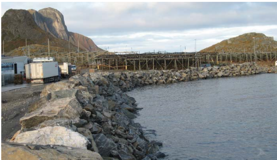
Fig 7 Foto av steinfylling mot Håkjerringvika sett mot nord.
