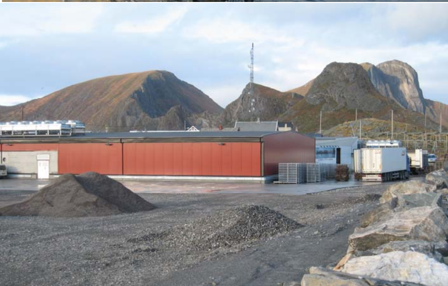
Fig 8 Foto atkomst til industriområde sett mot nord.
