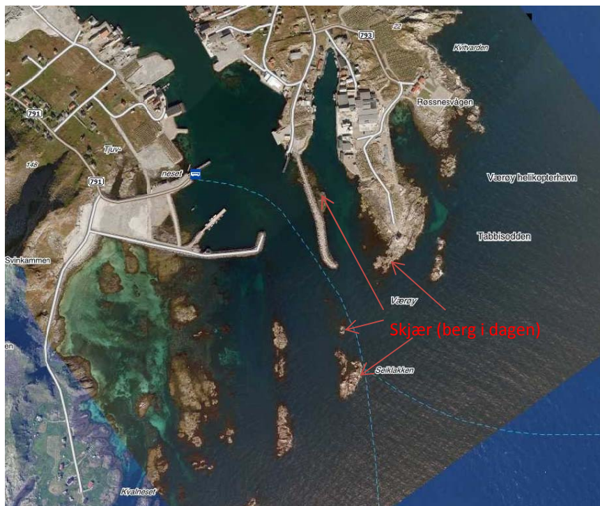
Fig. 3.2-1 Flyfoto av ytre del av Værøy havn.
