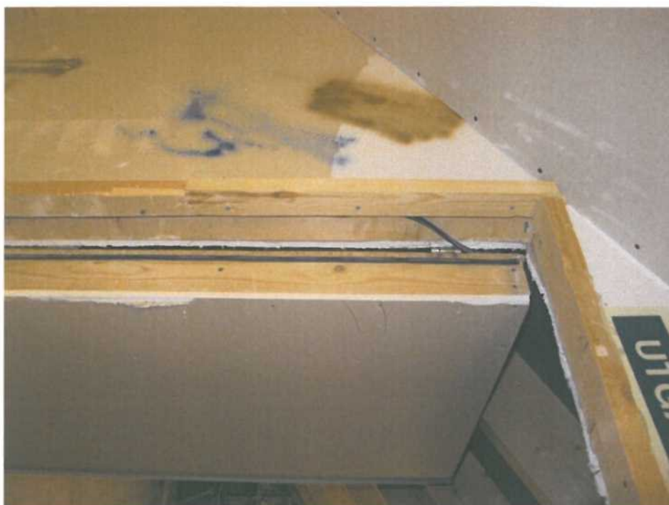
Figur 8 Uklassifisert dør i branncellebegrensende konstruksjon
