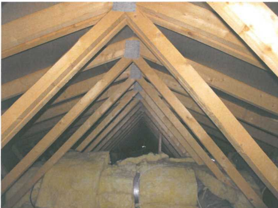
Figur 4 Stort åpent kaldt loft
